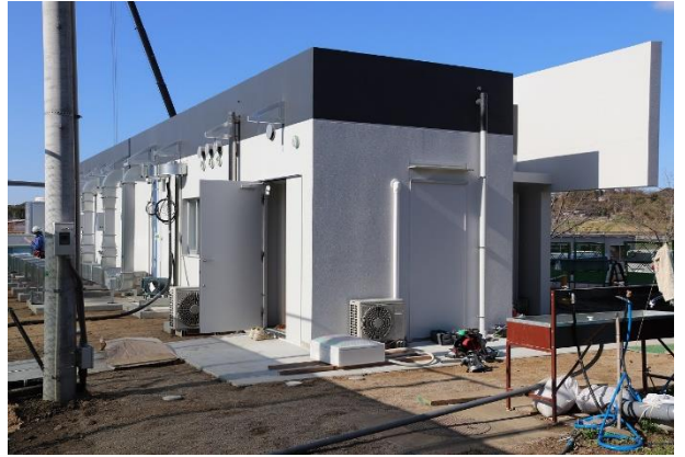
着々と改修工事が進む動物舎
